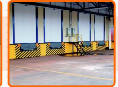
Do tipo de embutir na doca de carga, servindo de ponte com o veículo e acompanhando a sua oscilação durante a operação de carga e descarga;
